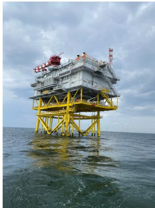
Figura 13. Subestación elevadora marina. Fuente: Elaboración propia
