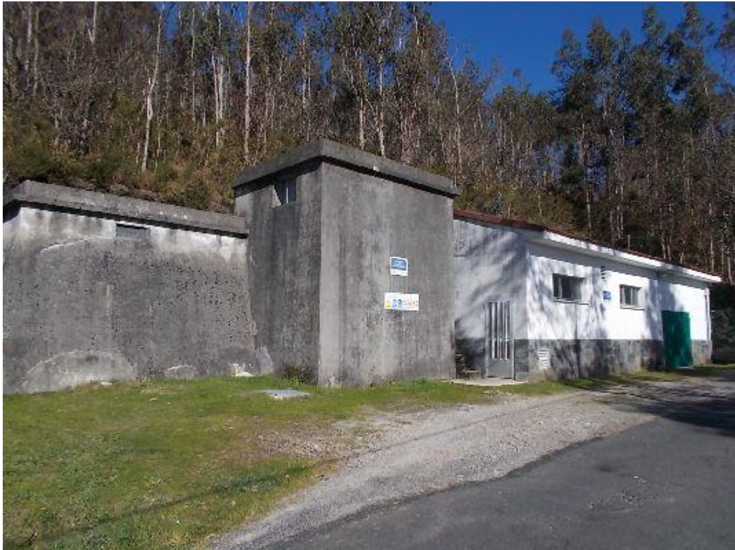
Afección ao depósito de auga da Baña
