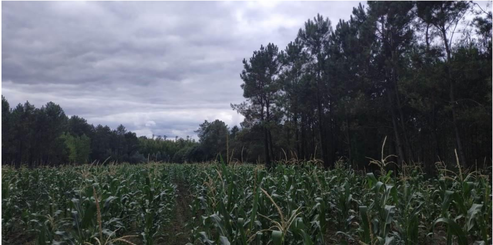
Apoio 1 de la LMT 30 Kv SET PE Vilartoxo
