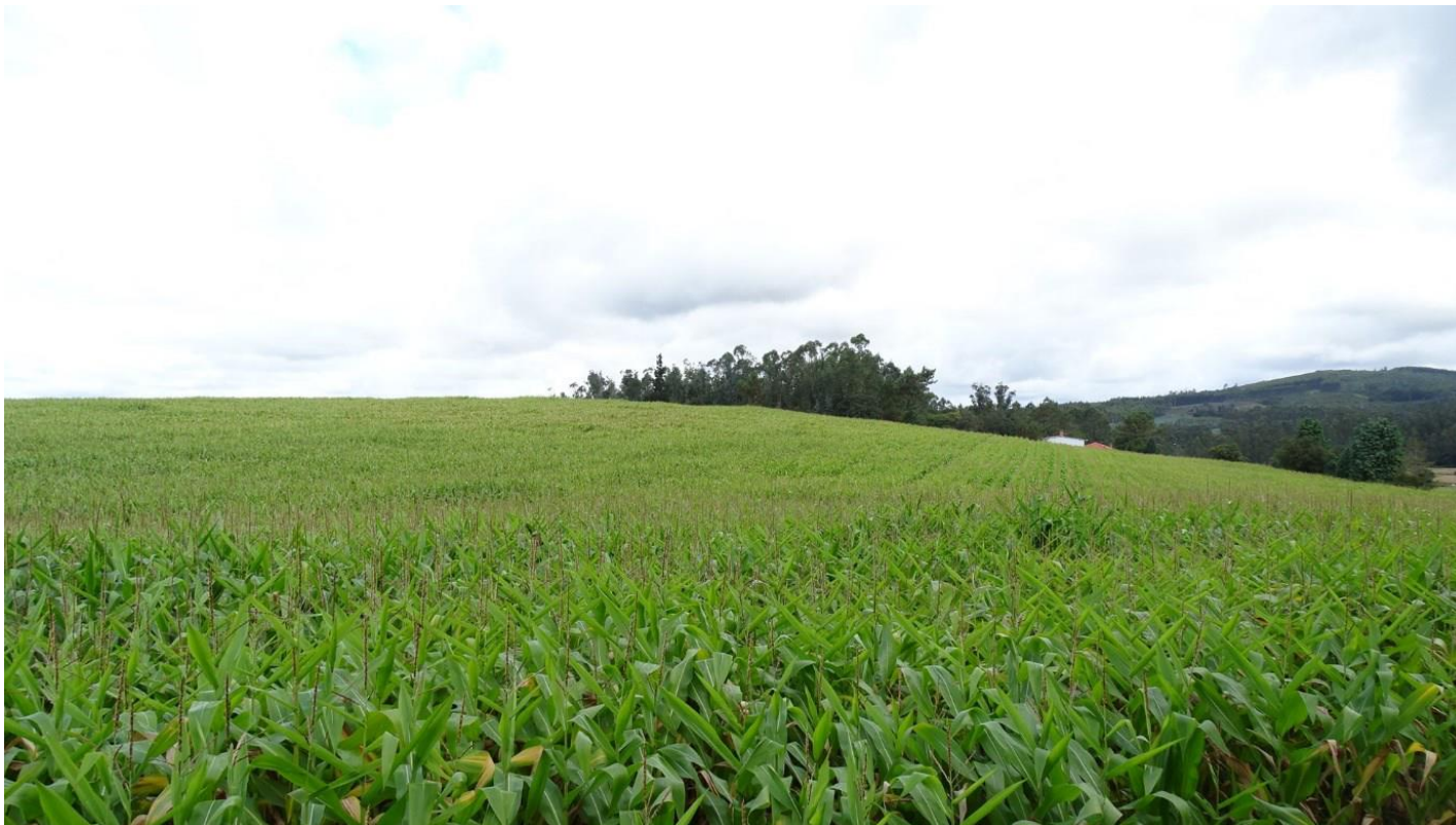
Vano 14-13 de la LMT 30 Kv SET PE Barrosino
