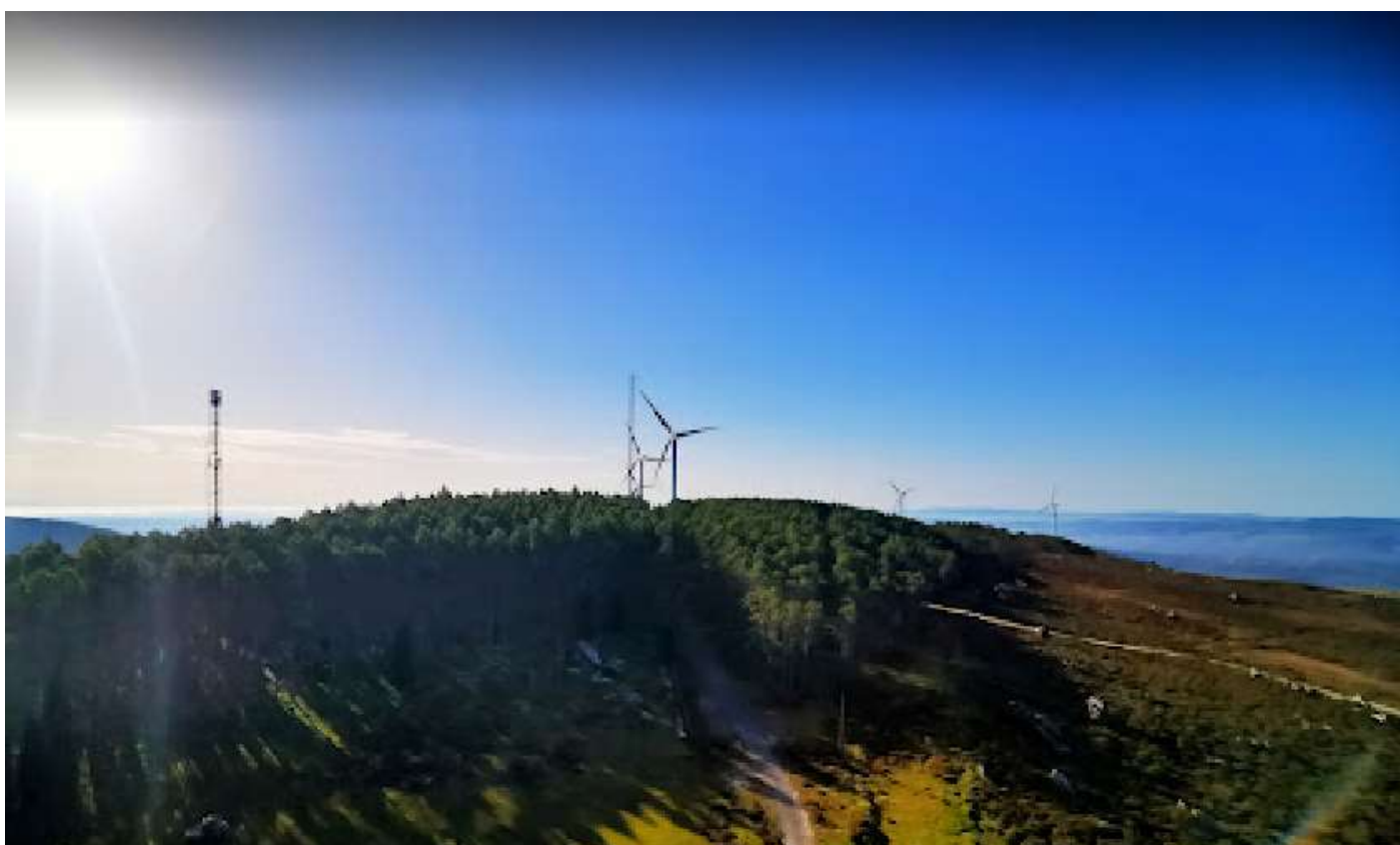
Vistas desde o Miradoiro de Goia -Peñote, severamente afectado polos aerogeradores xa instalados e en funcionamento. Perda da funcionalidade paisaxística do Miradoiro e xeración de Feísmo paisaxístico.
