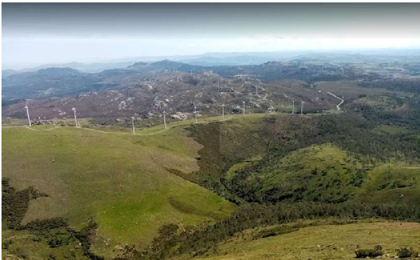
Miradoiro do Monte do Xistral, severamente afectado polos aerogeradores xa instalados e en funcionamento. Perda da funcionalidade paisaxística do Miradoiro e xeración de Feísmo paisaxístico
