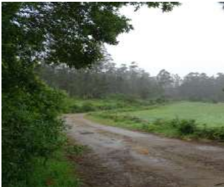
Pista na paraxe do Penedo afectada polas infraestruturas do proxecto eólico
