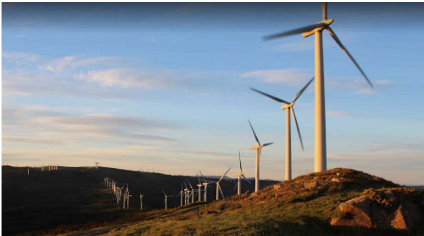
Mirador de Adraño, ateigado de aeroxeradores
