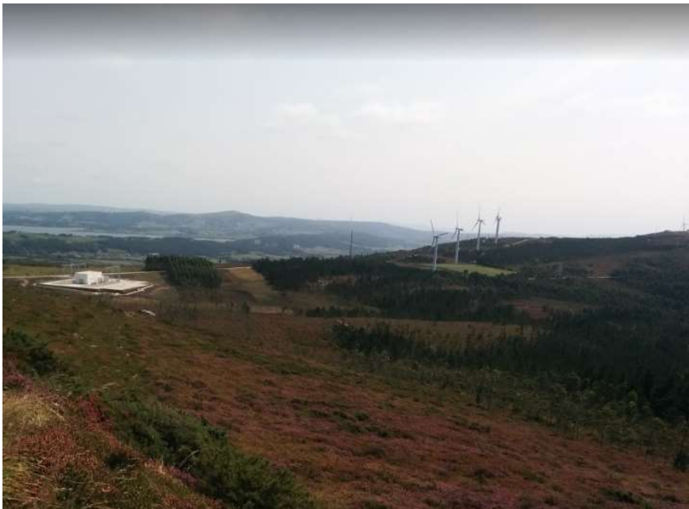
Vistas desde a Estación Remota de Salvamento Marítimo de Chan das Lagoas. Imaxe do parque eólico en funcionamento e da subestación eléctrica. Xeración de Feísmo Paisaxístico
