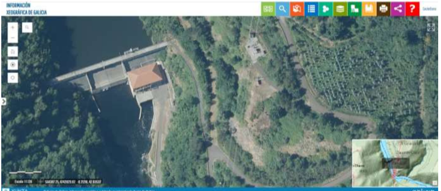
Detalle da Central hidroeléctrica de Brandariz, no Río Ulla e liña eléctrica de alta tensión e subestación
